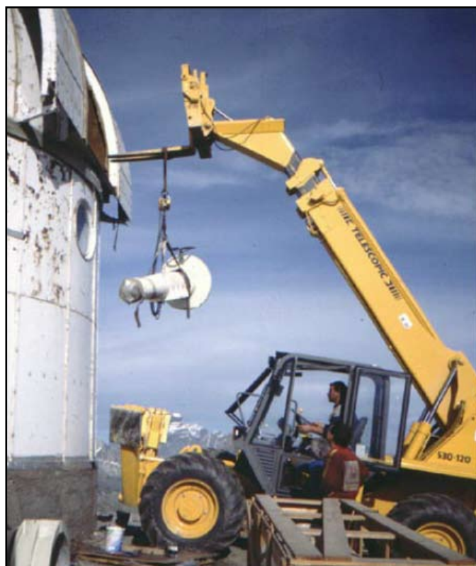
L'installation du T62 de l'OHP dans la coupole
